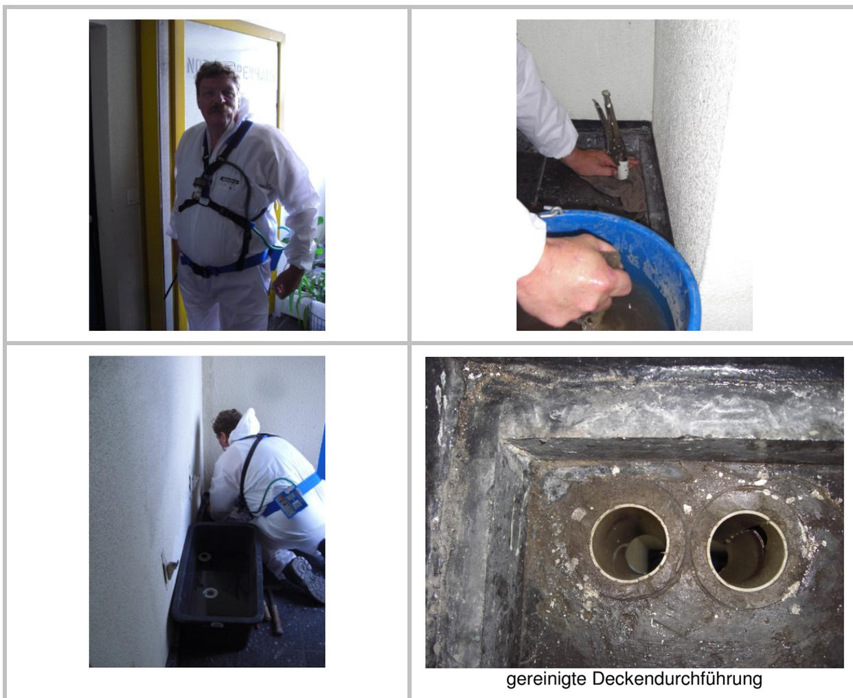
AN: Herr Schulz und ein weiterer AN - Trennen der Rohrleitung und Sichern der Deckendurchführung
