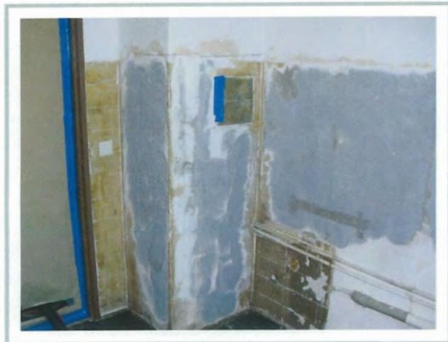
Die Oberflächen auf dem Beton und Porenbeton sind gleichmäßig und glatt abgefräst, hier liegt ein zufriedenstellendes Ergebnis vor.
